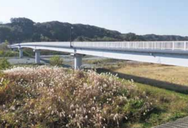
■永田橋 福生市とあきる野市を結ぶ重要な橋で平成23年3月、国内初の複合トラス 橋(スペーストラス構造)として完成しました。周囲の景観と調和が図られた 橋となり、ここからの眺めは素晴らしい景観です。
