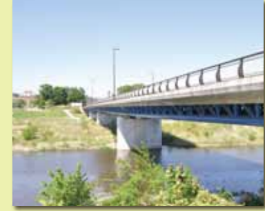
■永田橋 福生市とあきる野市を結ぶ重要な橋で平成23年3月、国内初の複合トラス橋（スパー・トラス構造）として完成しました。周囲の景観と調和が図られた橋となり、ここからの眺めは素晴らしい景観です。
